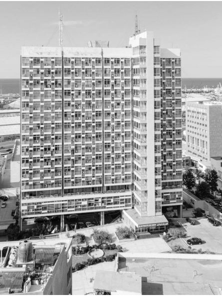
Bâtiment Electricité du Liban avant l'explosion
